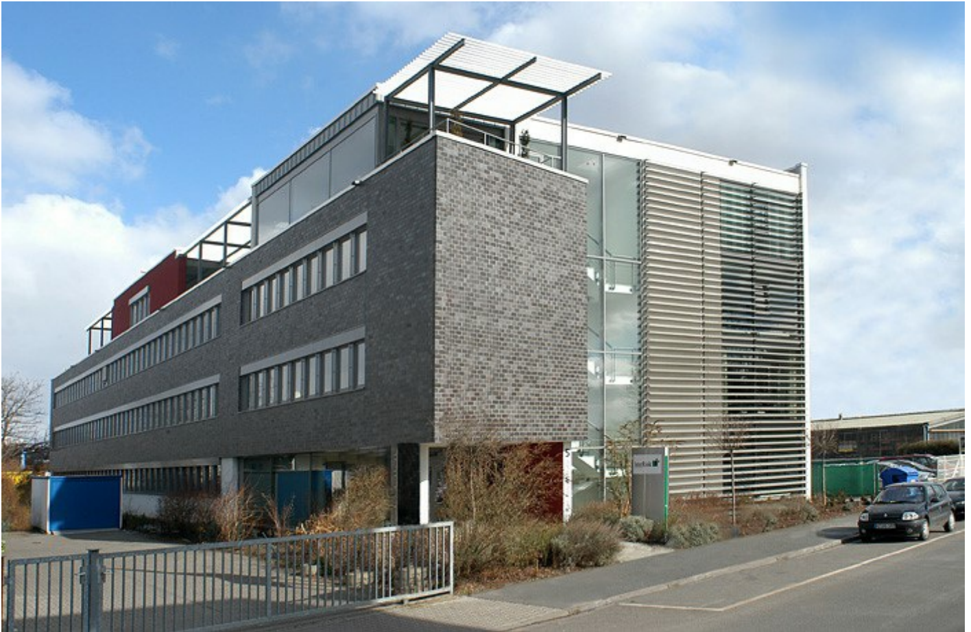
InterRisk Gebäude in Wiesbaden
